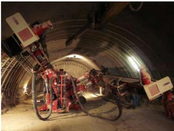
*Front d'attaque nord, Courrendlin: mise en place de tubes métalliques formant une voûte parapluie afin de stabiliser le rocher avec l'excavation.*
