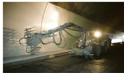
Travaux de peinture
