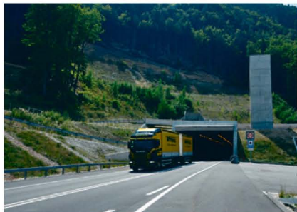
Tunnel du Graiteray
