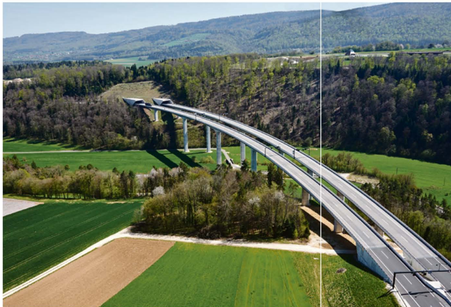
Viaducs du Creugenat
