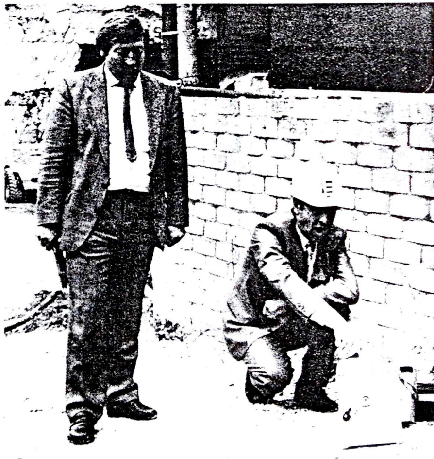
La mise à feu des mines par le ministre François Mertenat sous les yeux du président du Gouvernement Pierre Boillat; la surprise de la violence de l'explosion. (dg)
